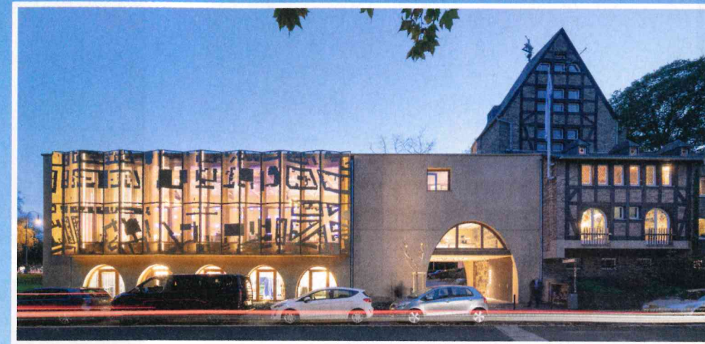
Gesamtansicht Seite Kartäuserwall bei Dämmerung. Neubau und Turm als zusammenhängendes Ensemble im Stadtraum
